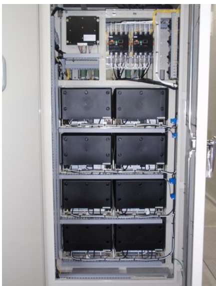
[バッテリーパック 50 kWh 実装状態]
