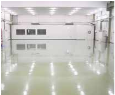
第2工場クリーンルーム クラス 10,000 広さ 542㎡
