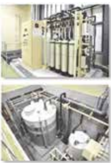
純水装置 (酸排水・回収排水ユニット併設)
