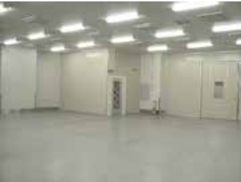
3Fクリーンルーム
