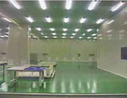
クリーンルーム
