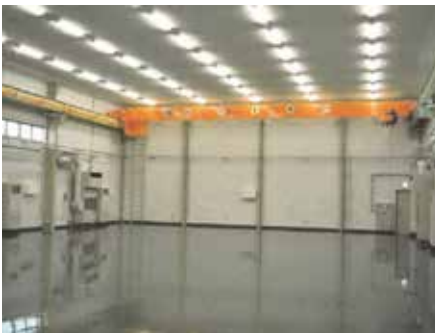
第2工場クリーンルーム クラス 100,000 広さ 424㎡
