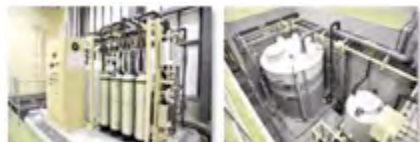
純水装置 (酸排水・回収排水ユニット併設)
