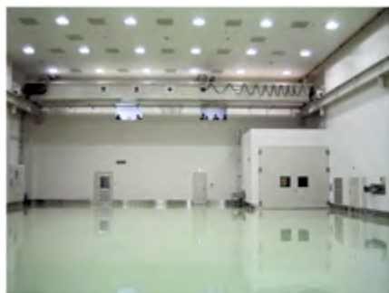
クリーンルーム（クラス：10,000、623m 2 ） 天井クレーン 4.8 t x 2 機
