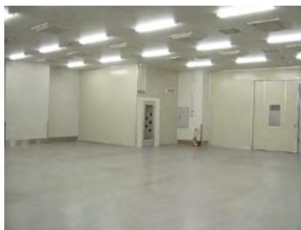
3 F クリーンルーム（クラス：1000、広さ：200m 2 ） 温度コントロール：室温 ±1℃可能
