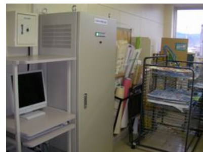
太陽光発電・系統連携蓄電装置 8kWh
